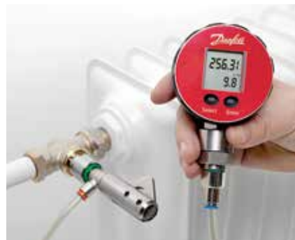
A Danfoss dP tool™ használata a radiátor ki-egyensúlyozására
