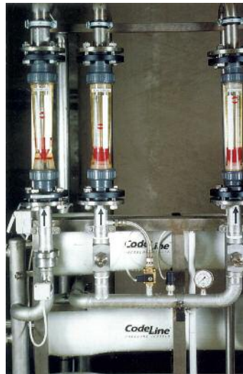
Fordított ozmózis berendezés rotamétere (áramlásmérő)
